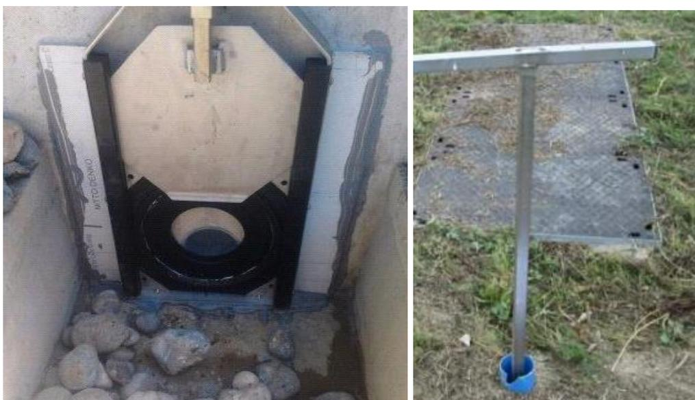
Figure 48 : Exemple de vanne de sectionnement pour eaux pluviales et dispositif de manœuvre
