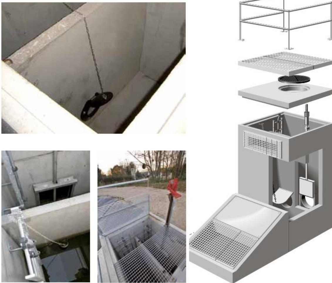
**Figure 14 : Exemple d'ouvrage de régulation de débit en sortie de bassin (Stradal)**
