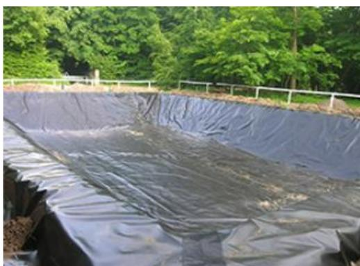
Figure 47 : Exemple de bâche d'imperméabilisation d'un bassin de rétention
